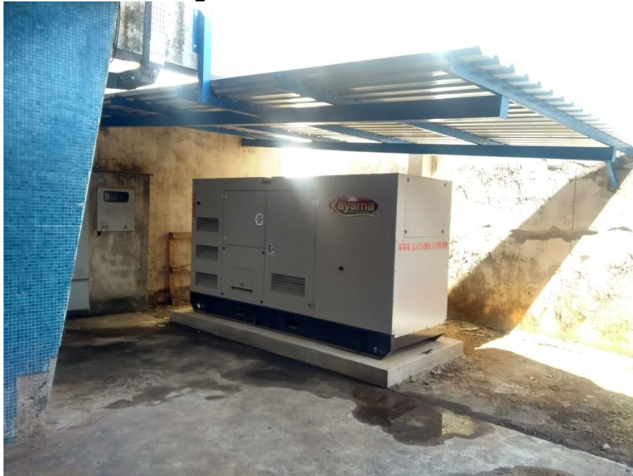
FOTO 01 - Base do gerador diesel
