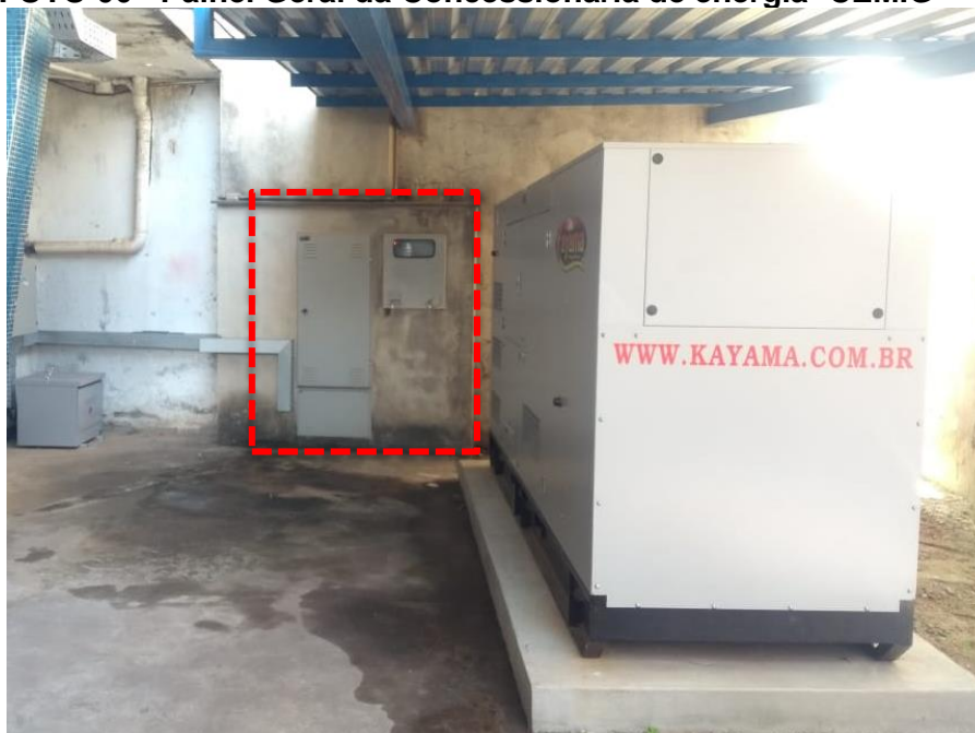
FOTO 06 - Painel Geral da Concessionaria de energia- CEMIG
