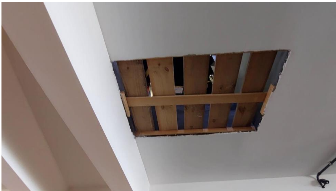
Local de instalação do sistema de ancoragem – 1º Pavimento Garagem
