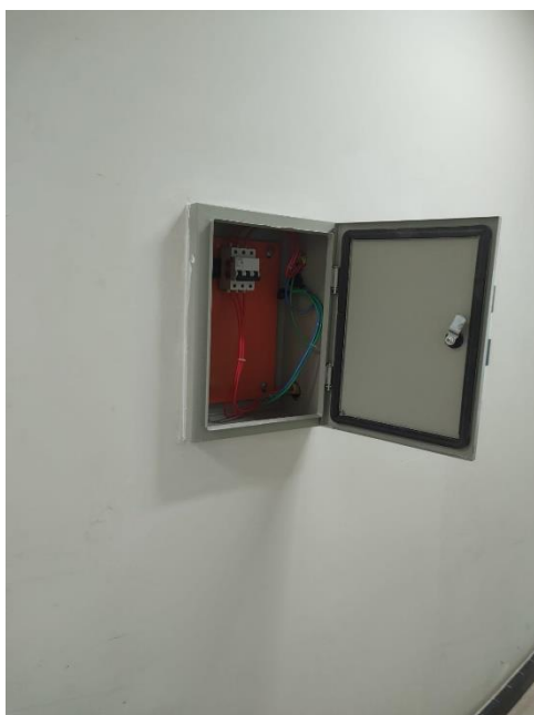
Quadro destinado a Plataforma Elevatória – 2º Pavimento Circulação.
